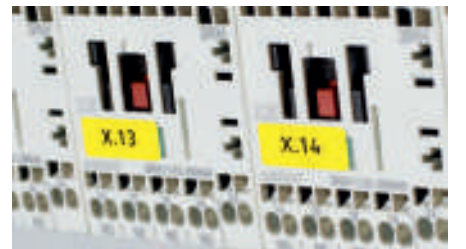
Kendinden yapışkanlı cihaz etiketi
