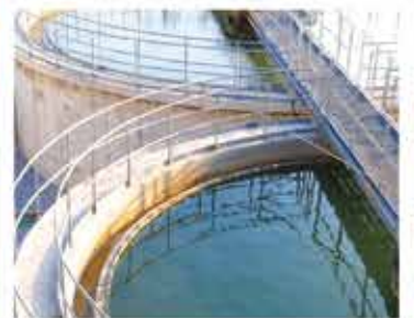
Su/ Atık su
