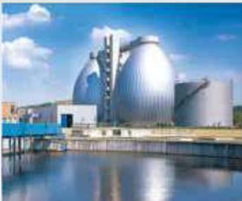
Su / Atık su istasyonu
