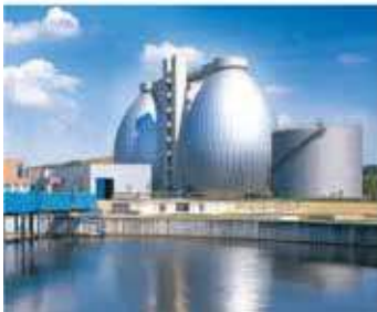
Su / Atık su istasyonu
